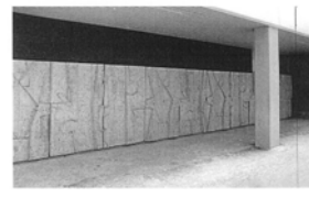
130 Wandgestaltung Hallenbad Steyr.jpg
